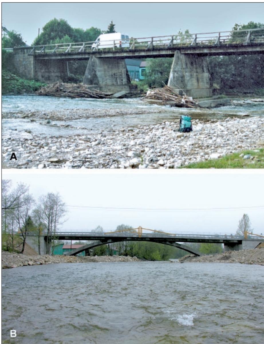
Fot. 4. Most na Czarnym Dunajcu w Chochołowie: (A) dawny most z filarami tkwiącymi w korycie rzeki, na których w czasie wezbrań w 2001 r. uformowały się zatory z napławionego drewna zmniejszające pole przekroju przepływowego; (B) most po przebudowie, z podtrzymującą konstrukcją łukową posadowioną poza korytem rzeki
