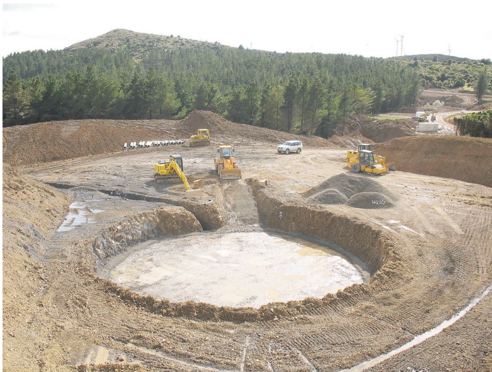
Fot. 2. Przekształcenia terenu spowodowane budową turbiny wiatrowej (typ Vestas V90, moc 3 MW, średnica rotora 90 m, farma Tararua, Nowa Zelandia) (fot. M. Feyen) – Land transformations due to construction of a wind turbine (the Vestas V90 type, power 3 MW, rotor's diameter 90 m, Tararua farm, New Zealand)
