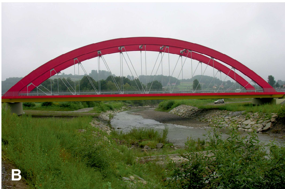
Ryc. 4. (A) Zablockowanie znacznej części przekroju mostu na Białej w Jankowej przez zatory z drewna napławionego w czasie dużej powodzi w maju 2010 r. było przyczyną szkód powodziowych w sąsiadującym obszarze dna doliny. (B) Przebudowany most w Jankowej umożliwia niezakłócone przepuszczenie rumoszu drzewnego przez przekrój mostowy w czasie wezbrań; ryc. 4A wg Hajdukiewicz i in. 2016, przedrukowano za zgodą Elseviera; ryc. 4B – fot. B. Wyżga
