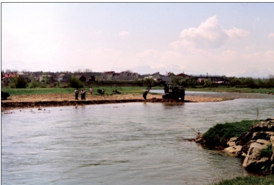
Fot. 1. Usuwanie całej objętości łachy żwirowej usytuowanej naprzeciw podcinanego wklęsłego brzegu Czarnego Dunajca w Nowym Targu, prowadzone w celu wyeliminowania zacieśnienia przepływu i odsunięcia nurtu od podcinanego brzegu
