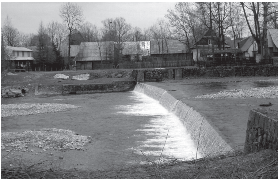
Ryc. 7.2. Przerwanie możliwości migracji ryb w rzece górskiej wskutek przegrodzenia jej koryta betonowym stopniem. Pomimo obecności przepławki w betonowej obudowie przeciwnego brzegu, jej boczne usytuowanie i brak prądu wabiącego stwarzają znikome szanse znalezienia wejścia do niej przez ryby.
