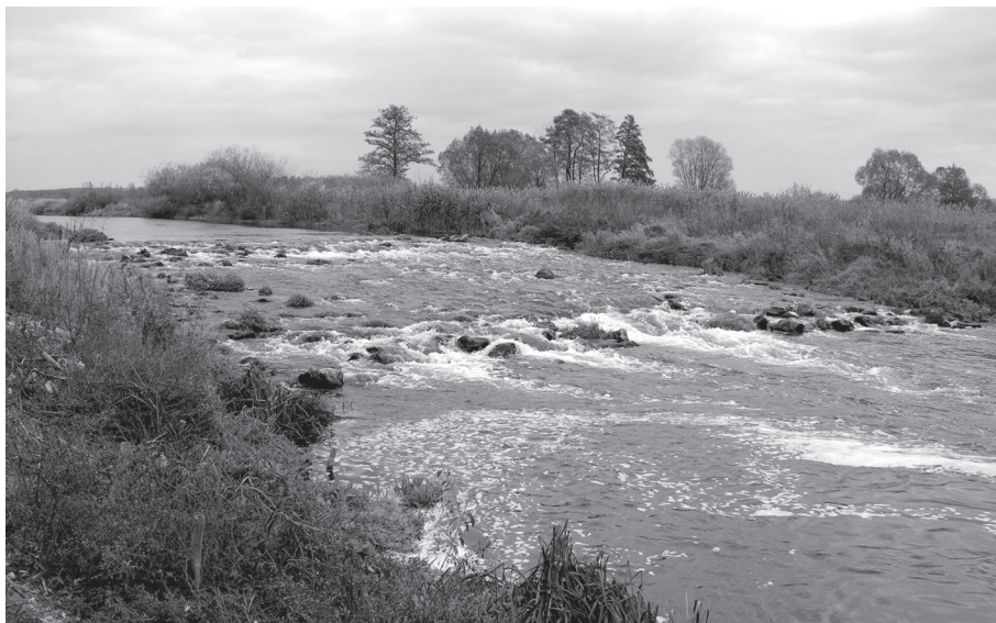
Ryc. 7.5. Sztuczne bystrze z głazów zmniejszające przepustowość koryta i ułatwiające rozpraszanie energii wód wezbraniowych.
