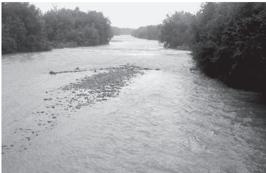
Ryc. 7.1. Szybki, skoncentrowany odpływ wód wezbraniowych wyprostowanym i zwężonym korytem regulacyjnym rzeki górskiej.
