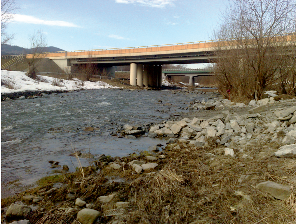
Ryc. 1. Rampa narzutowa z głazów w uregulowanym korycie poniżej serii mostów które powodowały zwężenie doliny i erozję denną potoku - przykład zasypania wyboju celem zachowania stanu dna uregulowanego koryta
