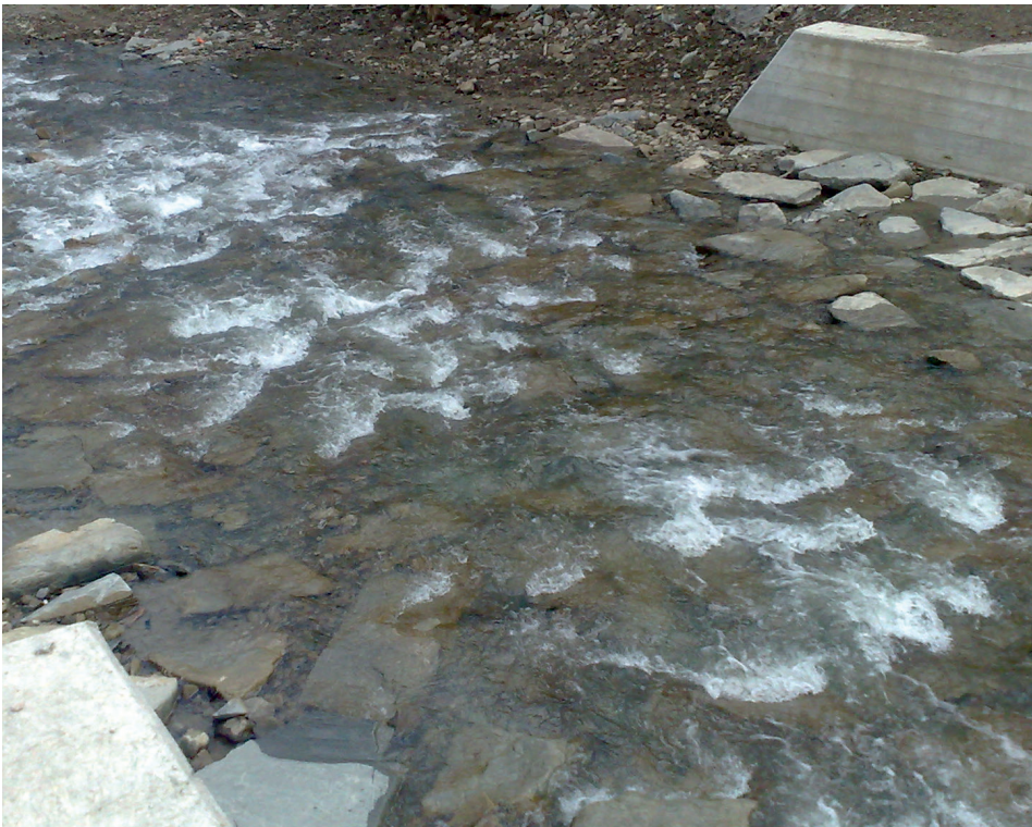
Ryc. 10. Widok z góry rampy wykonanej z „grouted rock” na dnie górskiego potoku poniżej przebudowywanej zapory przeciwrumowiskowej
