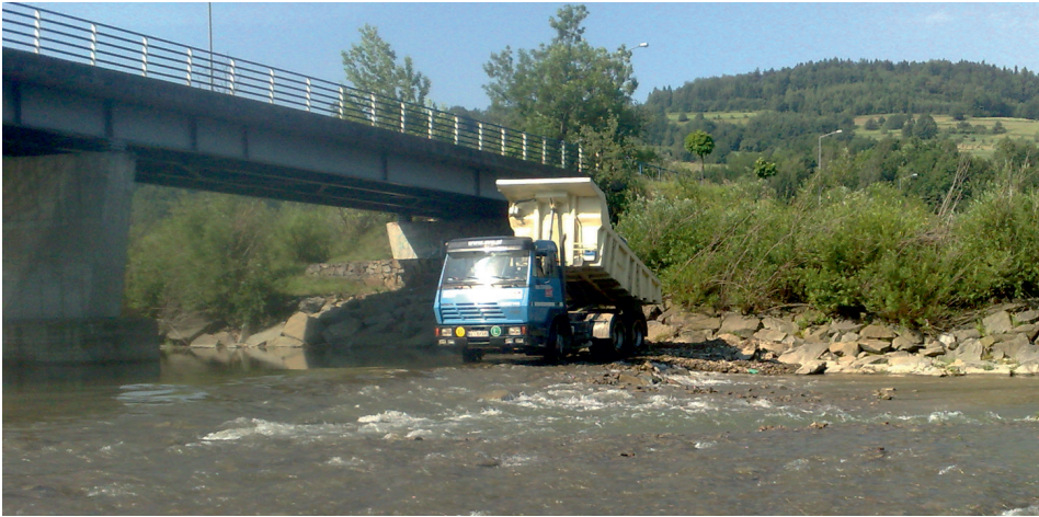
Ryc. 7. Zasypywanie wyboju pod uregulowanym wklęsłym brzegiem na koronie bystrza poniżej mostu – zagęszczanie przejazdami środków transportowych dowożących gruboziarnisty żwir do klinowania pustych miejsc pomiędzy głazami rampy narzutowej
