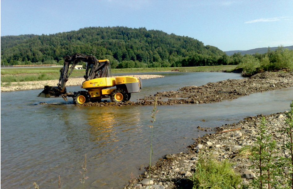
Ryc. 12. Czyszczenie wlotu do roztoki wypłyconej podczas wezbrania w wyniku depozycji materiału zwirowego
