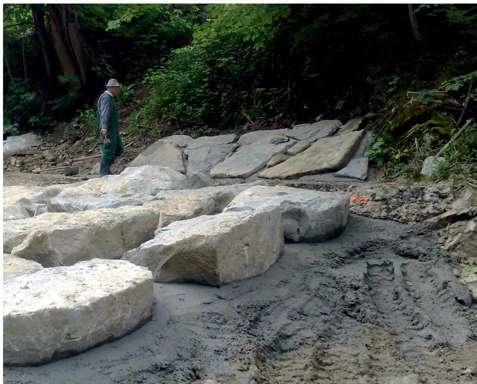
Ryc. 11. Układanie fragmentów skalnych w betonie na dnie i skarpach górskiego potoku celem uzyskania umocnienia typu „grouted rock”
