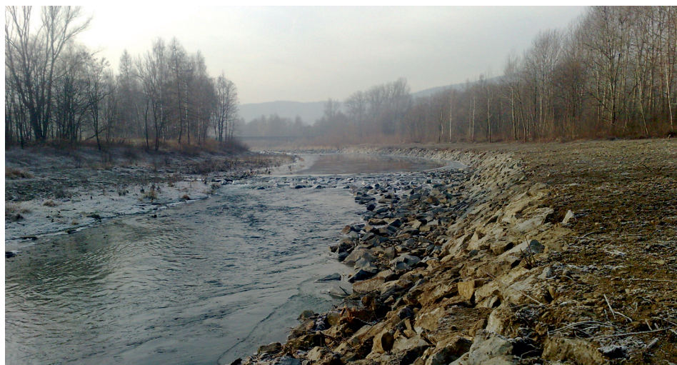
Ryc. 5. Korona naturalnego bystrza 1A skorygowana narzutem z grubego rumoszu skalnego o uziarnieniu 200/800 mm w ramach utrzymania wód, grudzień 2013
