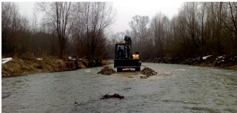
Ryc. 8. Dostarczanie żwiru do rzeki poprzez usypywanie wydłużonej przymy na tworzącej się łasze żwirowej w środku rzeki – przejazd sprzętu i transport wzdłuż usypywanej przymy
