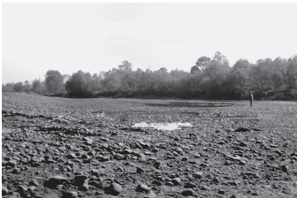
Ryc. 1.4. Usunięcie całej objętości łachy żwirowej usytuowanej naprzeciw podcinanego brzegu wklęsłego środkowej Raby, przeprowadzone w celu wyeliminowania zacieśnienia przepływu i odsunięcia nurtu od podcinanego brzegu.
