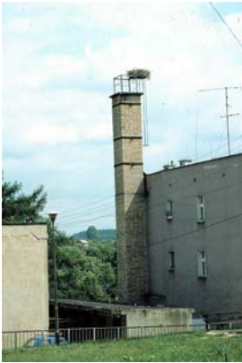
Fot. 4. Gniazdo na kominie ciepłowni w Radkowie (fot. R Mikusek).
