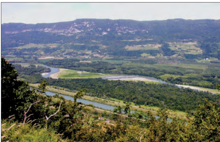
Fot. 6. Dolina Rodanu powyżej Lyonu z kanałem energetycznym o niewielkim spadku na przednim planie oraz korytem naturalnej rzeki w głębi
