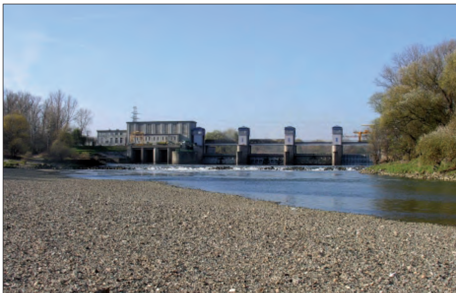
Fot. 2. Widok na stopień Przewóz od strony wody dolnej; widoczne kosze kamienno-siatkowe przegradzające koryto Wisły w odległości ok. 100 m poniżej stopnia, zapobiegające podmyciu stopnia w wyniku erozji wstecznej
