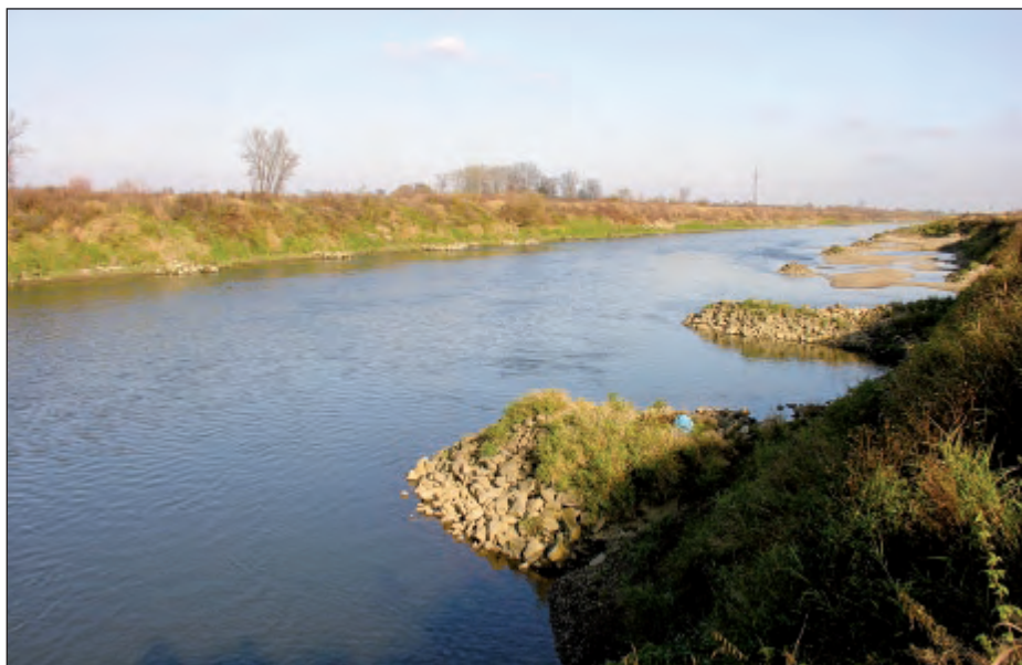
Fot. 5. Kamienne ostrogi w korycie Wisły w sąsiedztwie wsi Przylasek Rusiecki, zmniejszające szerokość czynnego przekroju koryta o ok. 1/3
