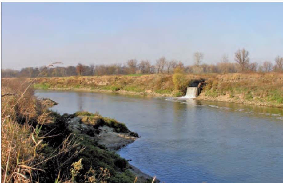
Fot. 1. Ujście lewobrzeżnego dopływu zawieszone ok. 2,5 m nad lustrem średnich wód w korycie Wisły jako wskaźnik erozji dennej rzeki poniżej stopnia Przewóz; widoczne także kamienne ostrogi zawężające koryto Wisły
