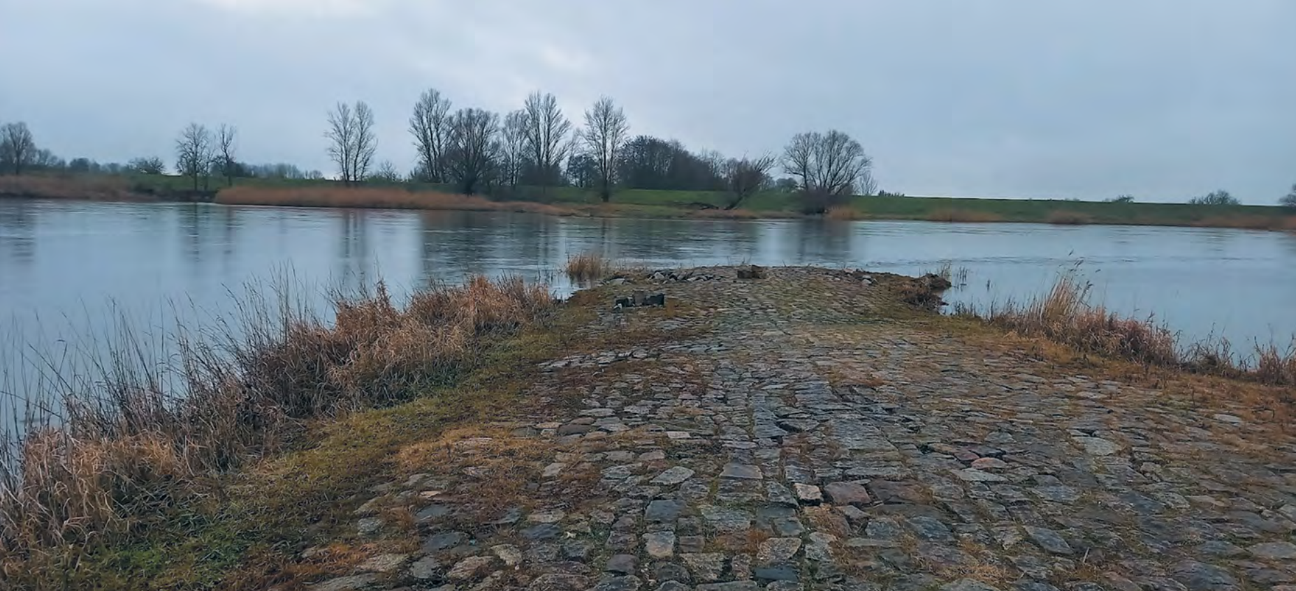
3 a–b | Ostrogi: u góry stara ostroga – widoczny sposób układania kamieni, poniżej jedna z nowych ostróg i narzut kamienny na brzegu fot. Karol Ciężak
