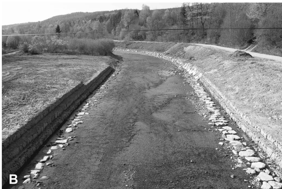
Fot. 1. Przykłady zbliżonych do naturalnych (A) i skrajnie przekształconych warunków (B) dla obecności erozyjnych i depozycyjnych form korytowych w górskiej rzece zwirodennej. W warunkach zbliżonych do naturalnych formy depozycyjne stanowią łachy żwirowe i kępy. Warunki skrajnie przekształcone cechuje brak poprzecznego i podłużnego zróżnicowania dna koryta na formy erozyjne i depozycyjne.
