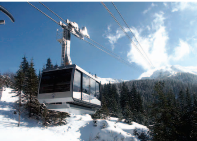
Ryc. 2. Zmodernizowana kolejka linowa na Kasprowy Wierch (grudzień 2012 r., fot. P. Skawiński)
